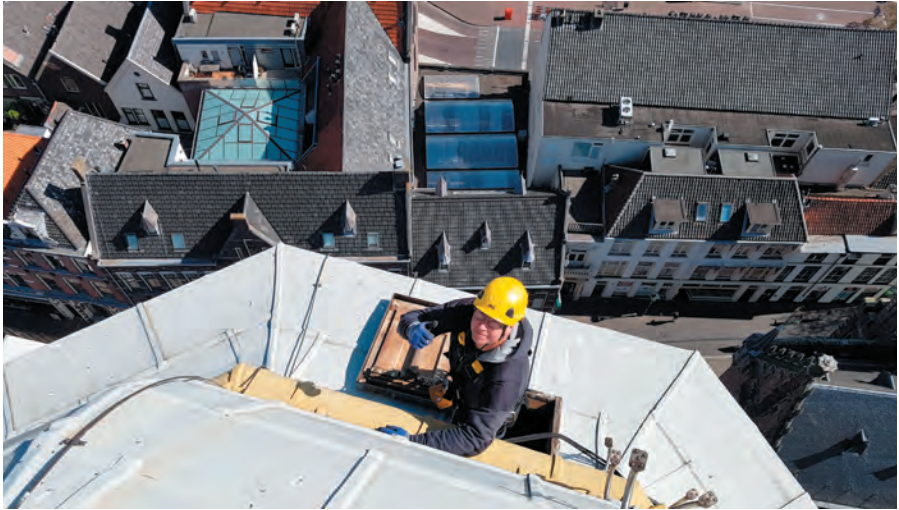
Inspectie van het loodwerk en de constructie van de helm van de Nieuwe Toren, gezien vanuit het kruis van de toren. Foto Henk de Bruin.
