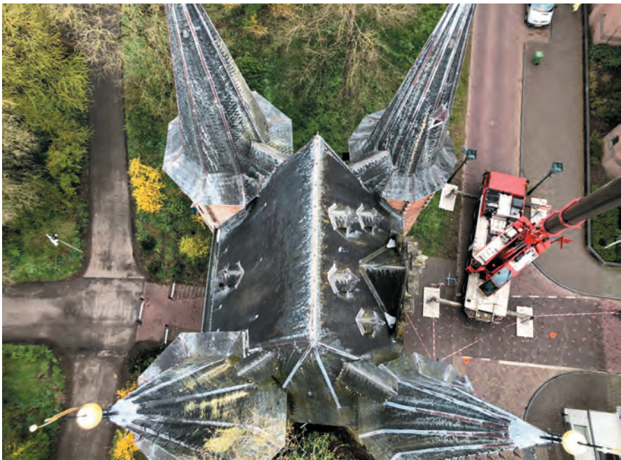
Vogelvluchtperspectief op de Broederpoort. Foto is gemaakt tijdens een inspectie met behulp van een kraanwagen. (2021). Foto Henk de Bruin.
