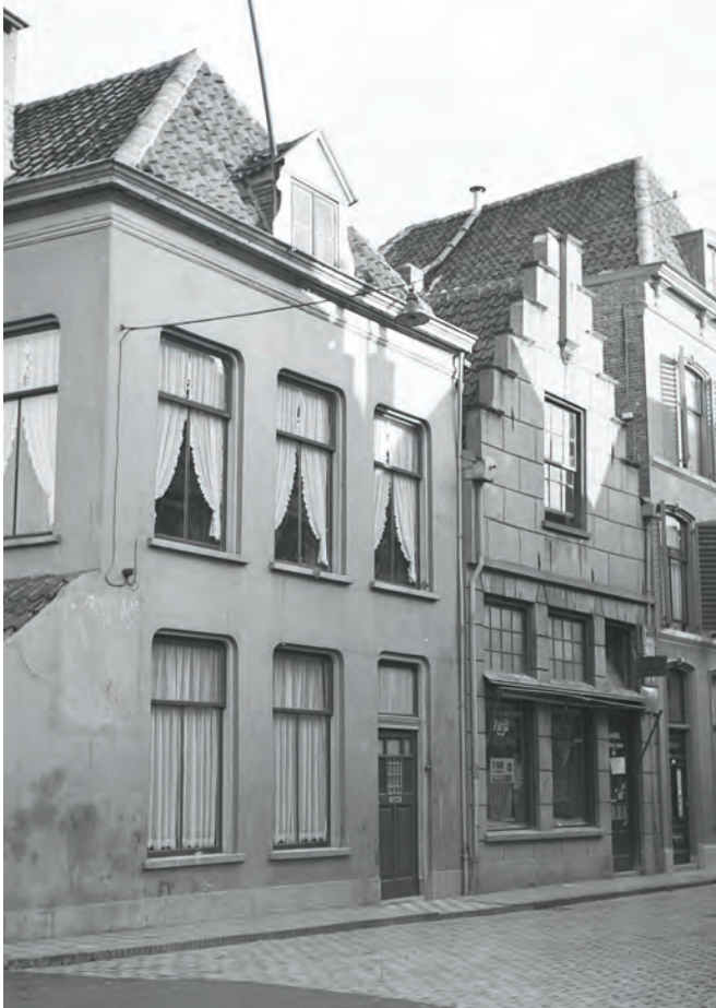
De gesloopte panden aan de Geerstraat. De trapgevel is nog in oude glorie aanwezig, evenals het ornament van de leeuw boven het raam van de eerste verdieping. Situatie 1937. Collectie SNS Historisch Centrum.
