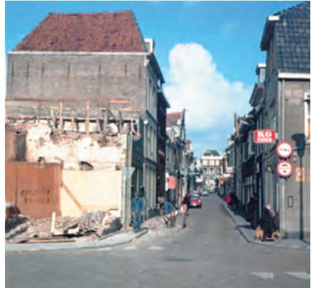
Dezelfde hoek tijdens de sloopectiviteiten. Collectie SNS Historisch Centrum.
