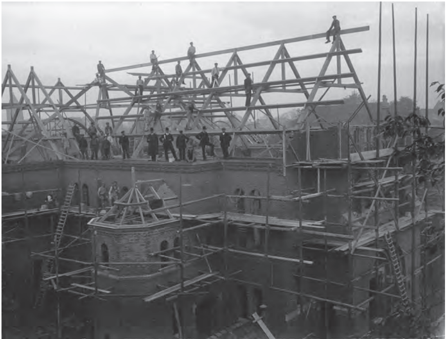
De bouw van de Gereformeerde Kerk aan de Broederweg. Foto: Atelier Sloot, Kampen. Collectie Stadsarchief Kampen.
