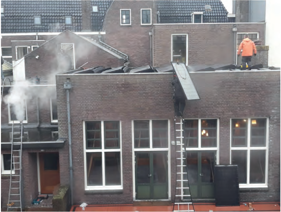
Het plaatsen van de zonnepanelen. Foto: collectie SNS Historisch Centrum.
