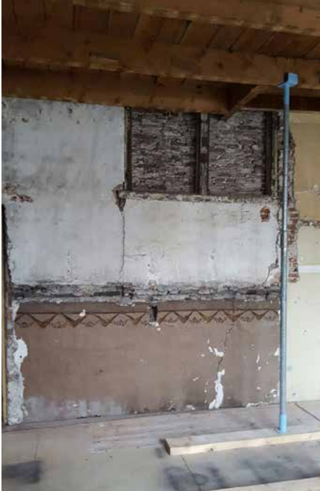
Achtergevel, vermoedelijk 15de eeuw, met bolkozijn en latere (1809) draperieschildering. Foto Geert Jan van der Schee 2016.
