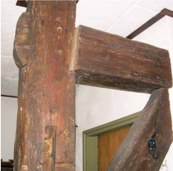
Gebint in de boerderij Bergweg 28. Onderaan de foto is in de gebintstijl een keep met toognagelgat te zien. Foto Chris Kolman.
