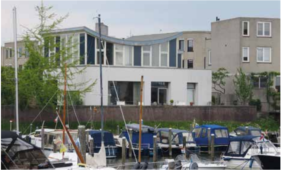
Bovenhavenstraat. Verbouwing van een bestaande woning, in opdracht van de familie Van Dijk-Westerhof. Omstreeks 1990. Foto: Collectie W. van 't Veen.
