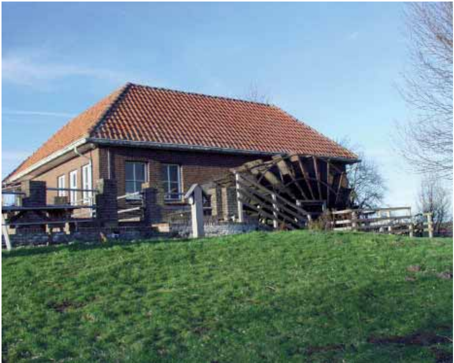
Gemaal aan de Flevoweg. In de 19de eeuw werd dit gemaal als een stoomgemaal gebouwd om de polder Broeken en Maten te bemalen. In 1929 werd het schepradgemaal omgebouwd tot een elektrisch gemaal. (Foto H. van der Werf, gemeente Kampen).
