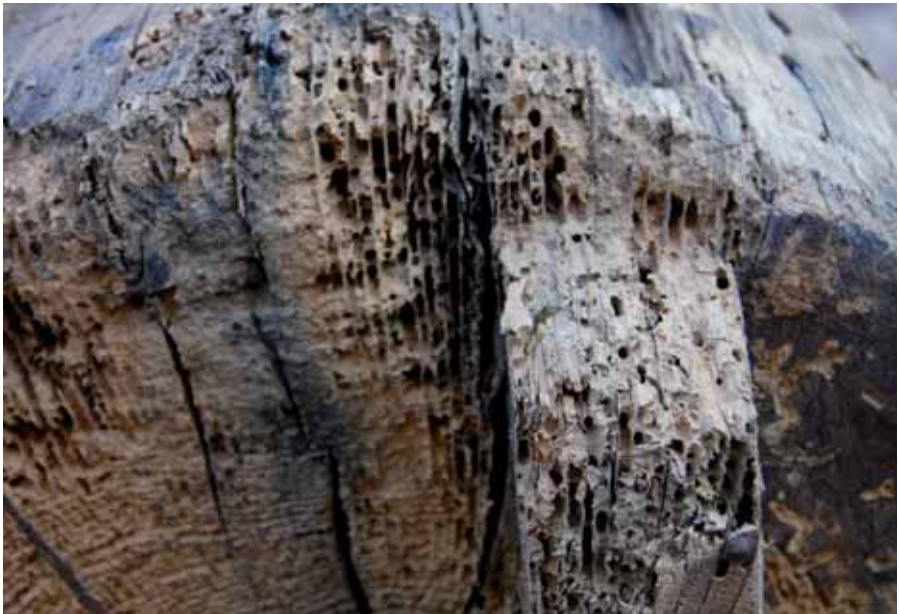
Houten verbinding met aantasting van de Bonte Knaagkever. Foto H. van der Werf, Gemeente Kampen.
