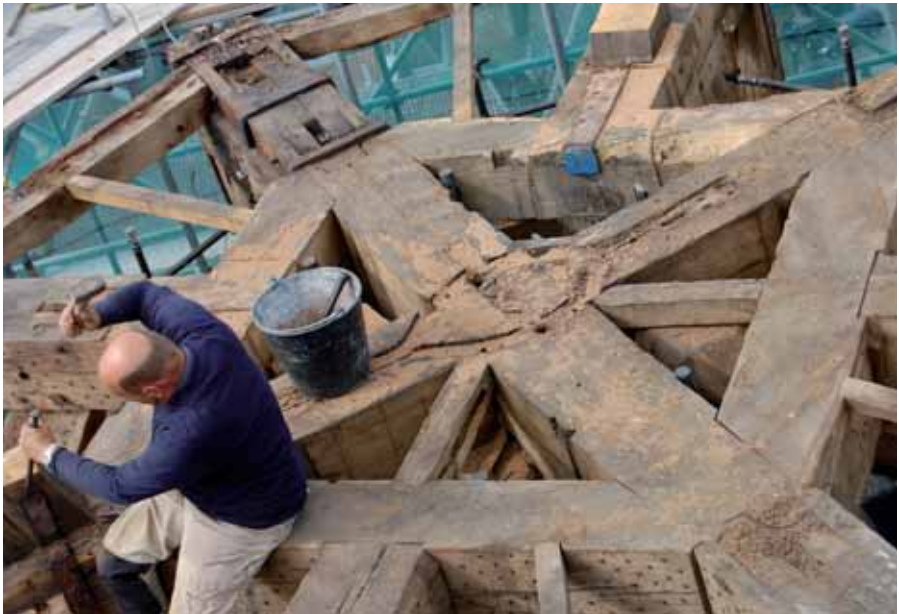
Demontage van de lantaarn. Foto H. van der Werf, Gemeente Kampen.
