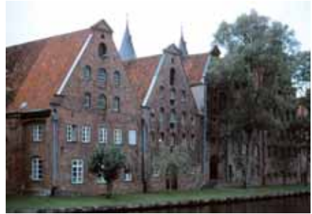
De 'Salzspeicher' (zoutpakhuisen) te Lübeck. 2000. Foto F.D. Zeiler.
