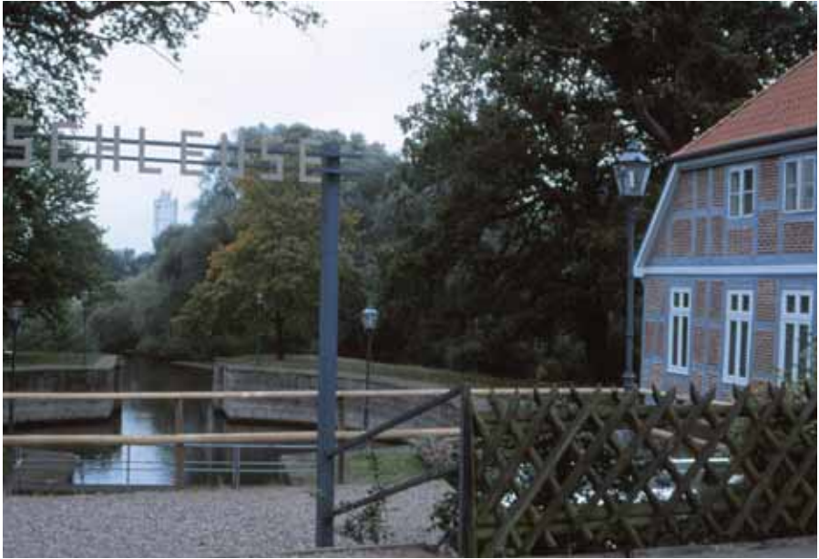
De historische sluis in het Stecknitzkanal bij Lauenburg. 1999. Foto F.D. Zeiler.
