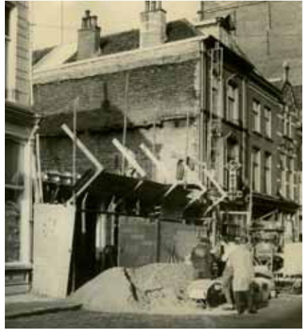
Wederopbouw na de brand van het winkelpand aan de Oudestraat.
