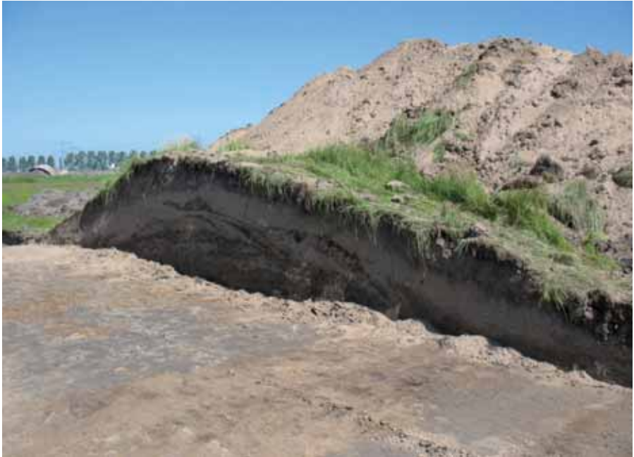
Profiel van de door werkzaamheden bij Ramspol doorsneden dijk. Foto: Alexander Jager.
