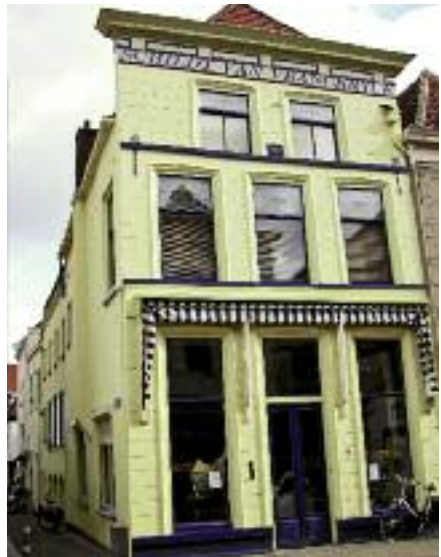
Middeleeuws huis aan de Melksteeg waarvan de voorgevel in de loop der jaren sterk is aangepast aan latere architectuurstijl.
