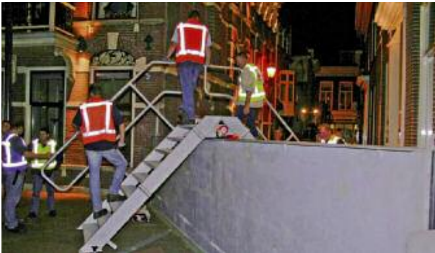
In stegen en straten kunnen grote schuiven worden opgedraaid door de hoogwaterbrigade. Wie vóór de muur woont kan alleen via een trap de binnenstad bereiken, zoals hier bij de Marktgang. Fotostudio Freddy Schinkel.
