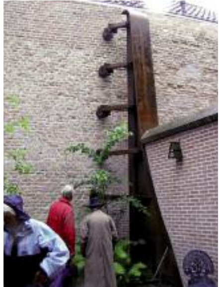
De oude stadsmuur fungeert nog vaak, zoals hier, als achtermuur van huizen in de Voorstraat. Daar waar die muur niet stabiel is, zijn reuzengrote stalen steunbalken aangebracht.
