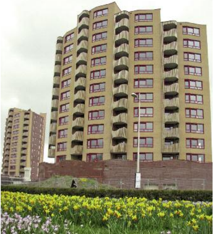
Renovatie van de Hanzewijk.
