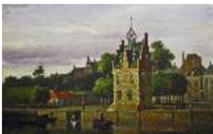
Het Tolhuisje geschilderd door J.J.Fels, ca 1845 (enkele tientallen meters ten zuiden van de brug). Stedelijk Museum Kampen.
