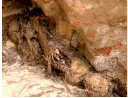
Houten funderingspalen van de Hagenpoort, 2008. Foto: Alexander Jager.
