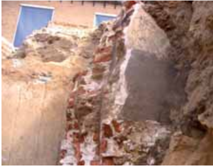
Westelijk muurwerk van de Hagenpoort met 19de-eeuws pleisterwerk, 2008. Foto: Alexander Jager.
