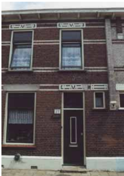
In de lateien heeft architect Broekema voor de levendigheid de initialen van Eenvoud verwerkt. Foto Wim van 't Oever.
