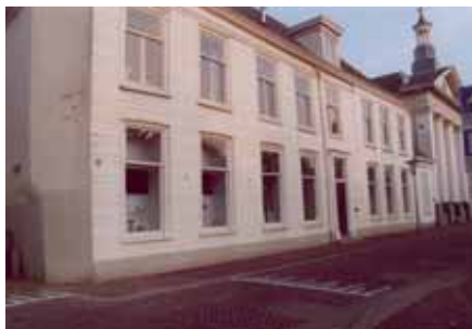
Bouwvereniging Eenvoud werd in 1906 opgericht ten huize van dokter Veer Valck, Burgwal 86. In de loop van de jaren kreeg het gebouw verschillende bestemmingen. Nu bouwt woningcorporatie Deltawonen er appartementen in. Foto Wim van 't Oever.
