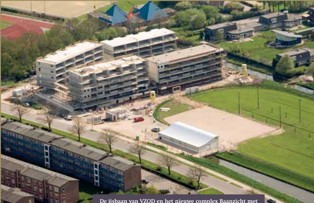
De ijsbaan van VZOD en het nieuwe complex Baanzicht met 86 seniorenappartementen aan de Beneluxweg
