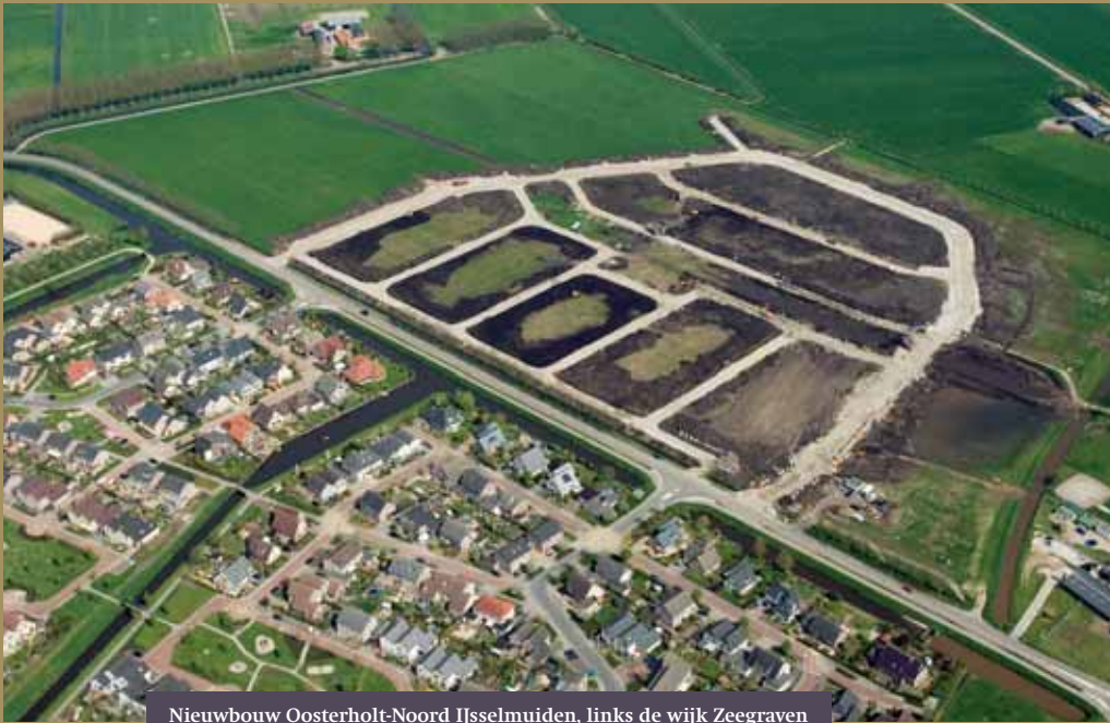
Nieuwbouw Oosterholt-Noord IJsselmuiden, links de wijk Zeegraven
