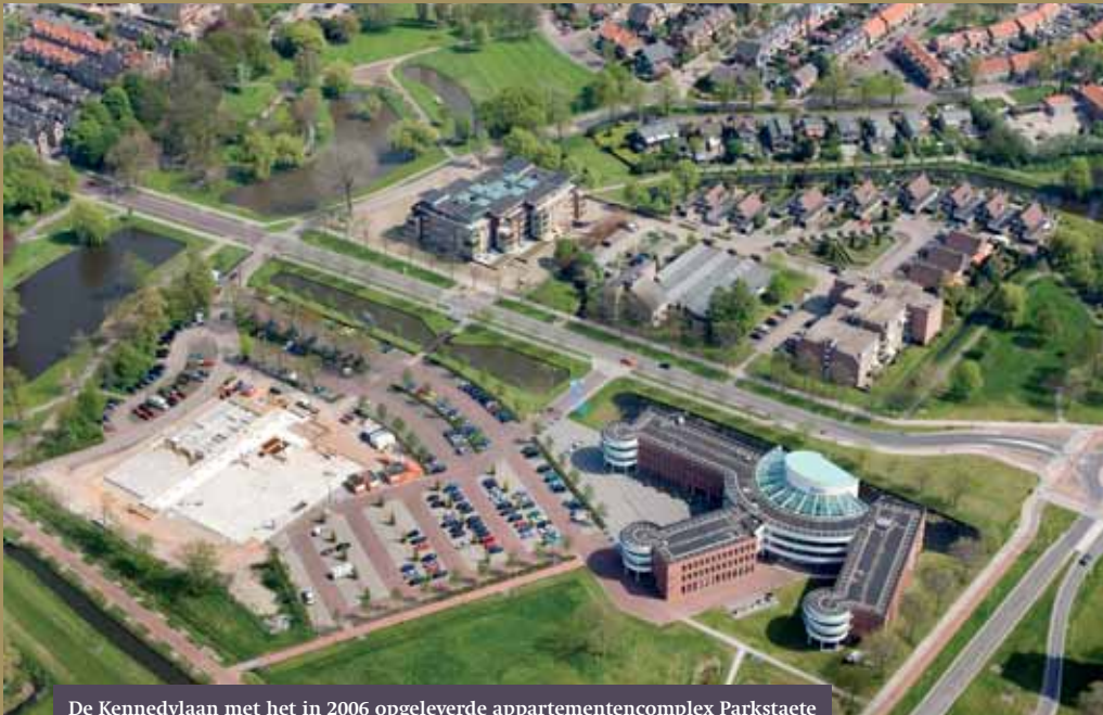
De Kennedylaan met het in 2006 opgeleverde appartementencomplex Parkstaete en de eerste fase van de nieuwbouw van sporthal De Reeve
