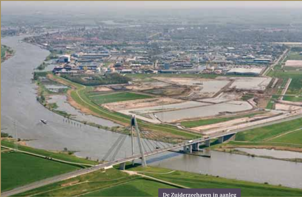
De Zuiderzeehaven in aanleg
