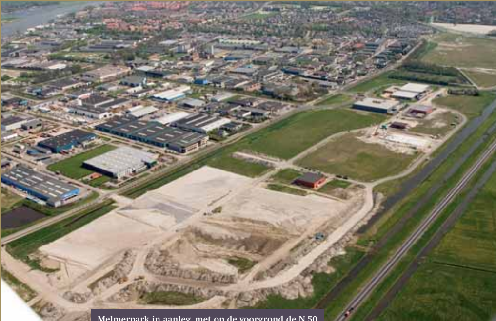
Melmerpark in aanleg, met op de voorgrond de N 50
