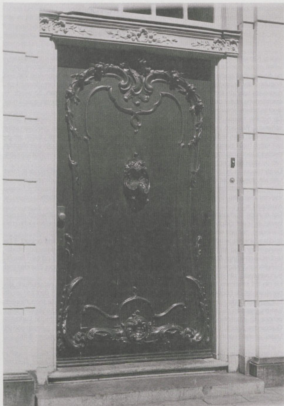
Deur van het pand Oudestraat/hoek Dwarssteeg. De gevel is laat-Lodewijk XIV-stijl. In de kroonlijst staat in Romeinse cijfers het jaartal 1764. Gelukkig is deze deur van de ondergang gered.
