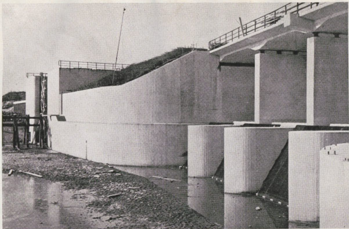
De zuigmonden van het gemaal „Wortman” in Oostelijk Flevoland.
