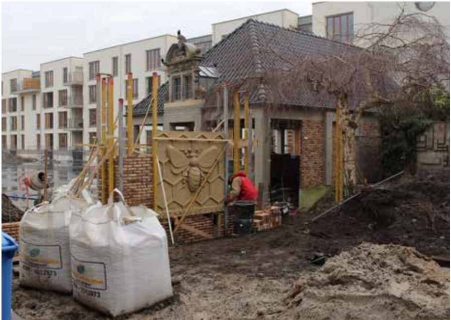
Januari 2016. Het in metselen van het betonnen reliëf in de scheidingsmuur tussen het nieuwe woonzorgcomplex Margaretha en de tuin van het SNS Historisch Centrum. Collectie SNS Historisch Archief. Foto: Herman Harder.
