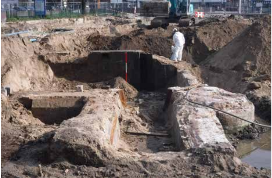
Overzicht van het muurwerk van het sluisrestant. Foto: Econsultancy.
