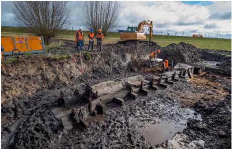
Onbekende houten constructie bij de Enkkolk. Foto: Freddy Schinkel
