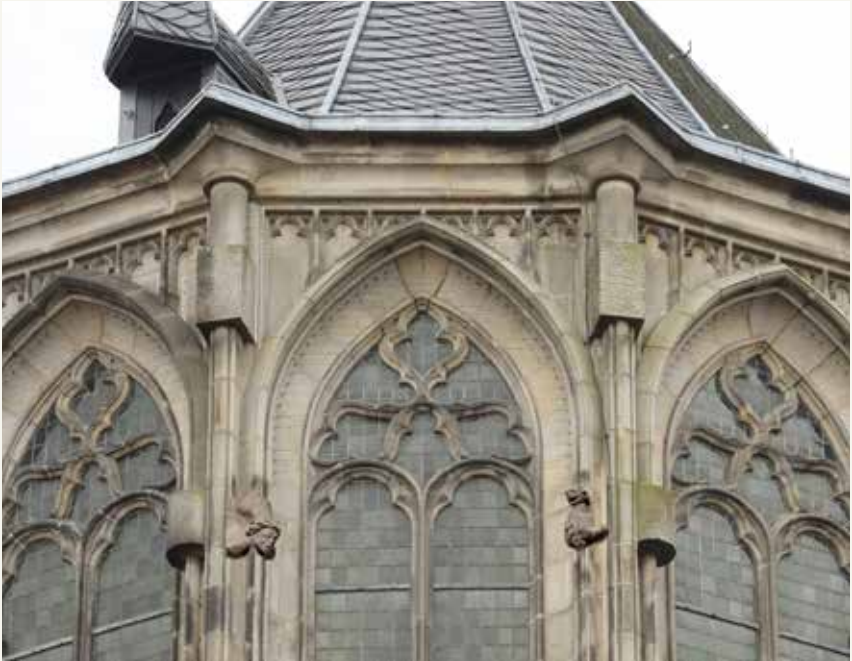
Oostsluiting van het hoogkoor van de Bovenkerk met daarin gefotoshopt twee van de vier sculpturen in de collectie van het Stedelijk Museum Kampen. De bij de restauratie aangebrachte rechthoekige steenblokken erboven suggereren de aanzetten van vroegere luchtbogen. Foto en fotomontage Ernst Hupkes.
