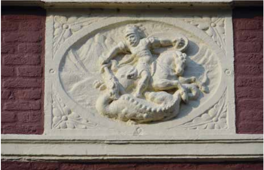
Gevelsteen van St. Joris van het pand aan de Boven Nieuwstraat 100. Foto: Remy Steller.
