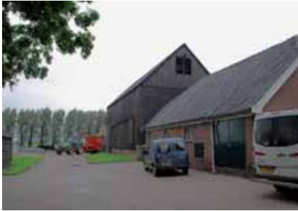
Bisschopswetering 92. De hoge, houten, zwart geteerde hooischuur op het achtererf is een markant gebouw dat zeldzaam is geworden. Foto: Het Oversticht.
