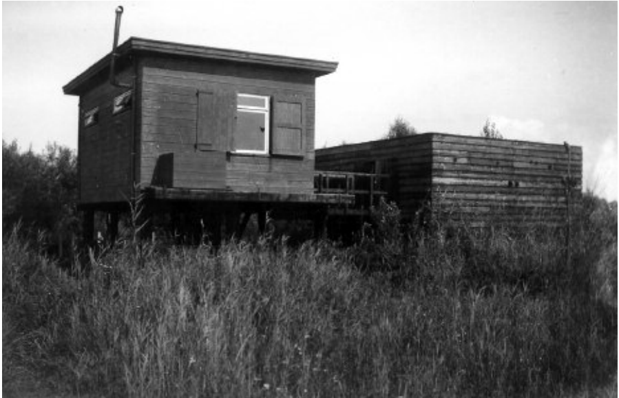
Gecamoufleerde bunker, foto 1940-1942, bron: archief de heer Overwater.
