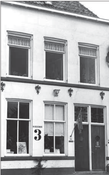
Galerie 3, Burgwal 96 in Kampen
