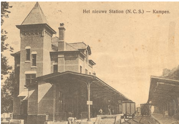
Het Station van de Nederlandse Spoorwegen in Kampen. (foto collectie FWA)
